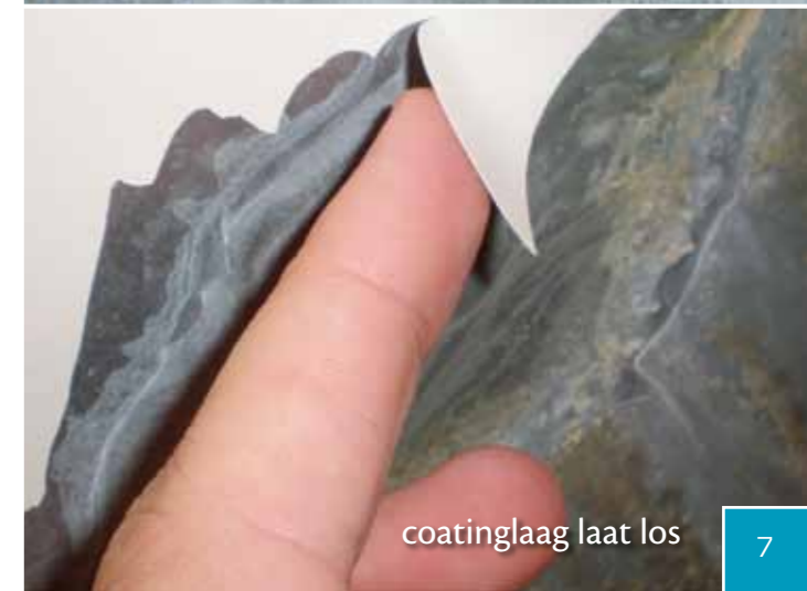
beschadigde tegelwand
